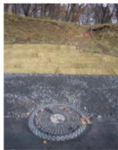
写真4 事業者のマンホールと仮舗装
