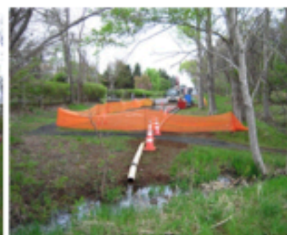
写真8 汲み上げた地下水が排水され
