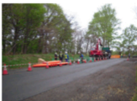
写真7 オレンジ色のパイプの埋設工事
