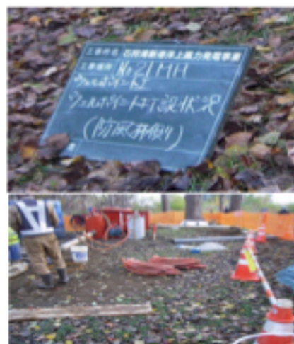
写真2 ウェルポイント工法
