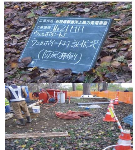
写真2 ウェルポイント工法
