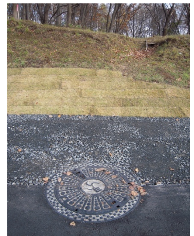
写真4 事業者のマンホールと仮舗装
