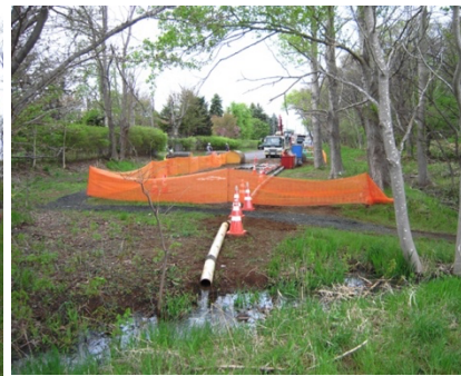
写真8 汲み上げた地下水が排水され
