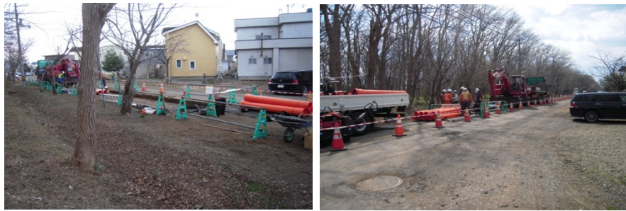
写真6 オレンジ色のパイプの埋設工事
