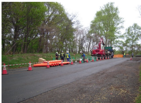
写真7 オレンジ色のパイプの埋設工事
