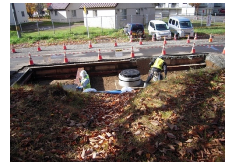
写真3 マンホールを埋めていた
