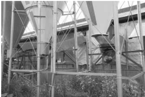
写真4. 飼料タンク下部のゴムパイプをヒグマが引きちぎって壊した跡(右)。左の2つは鉄板で囲いつけている 上川町
