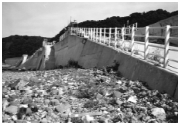
島牧海岸の堤防 (高さ7m 村役場職員談)
